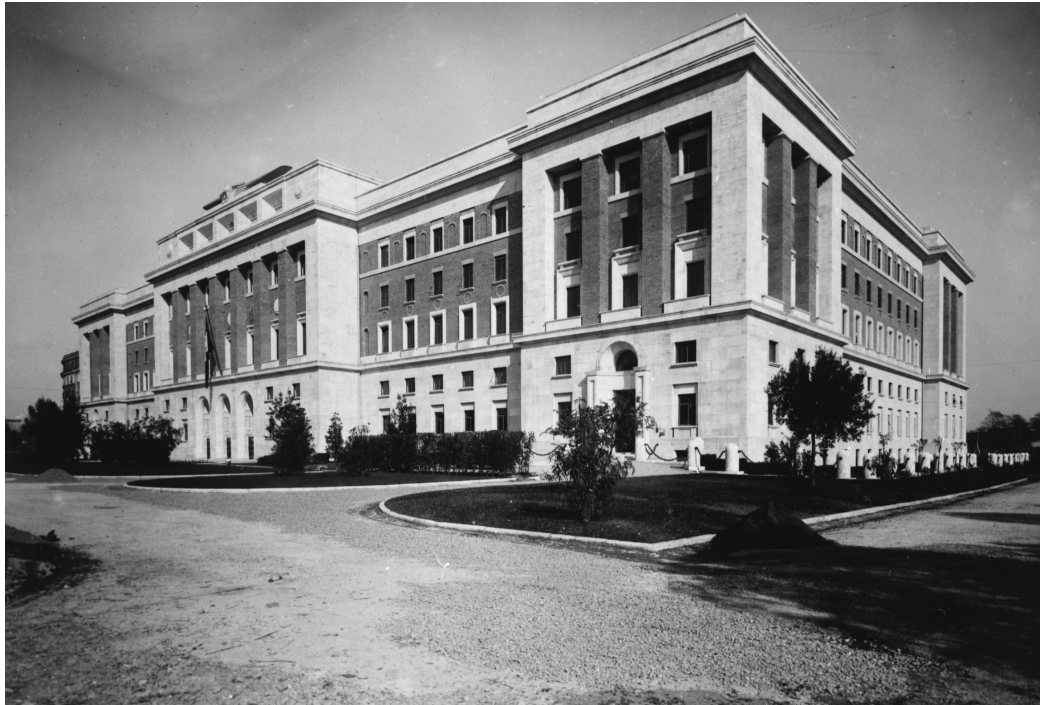
Fig. 1 - Roma, R. Marino, palazzo Aeronautica, il prospetto principale verso viale Pretoriano (ante 28 ottobre 1931). In evidenza la strutturazione figurativa ternaria in basamento, piani superiori e attico nella stratificazione dialettica di travertino e mattoni (Stato Maggiore dell'Aeronautica Militare, V Reparto, per gentile concessione con divieto di ulteriori riproduzioni).
