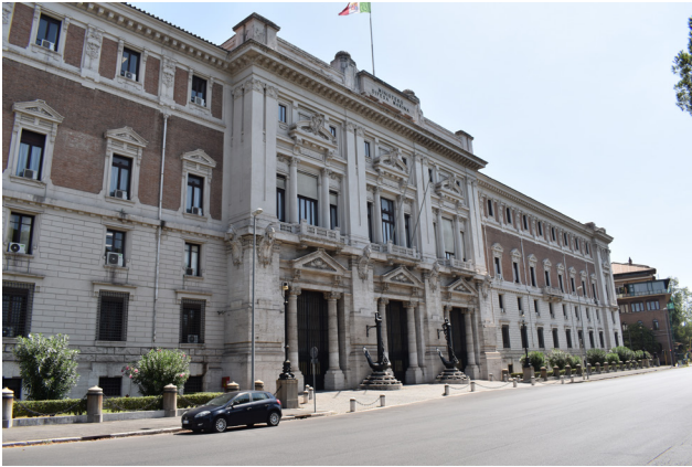
Fig. 2 - Roma, Giulio Magni, palazzo della Marina sul lungotevere Flaminio, 1928 (foto dell'autore, 2021).
