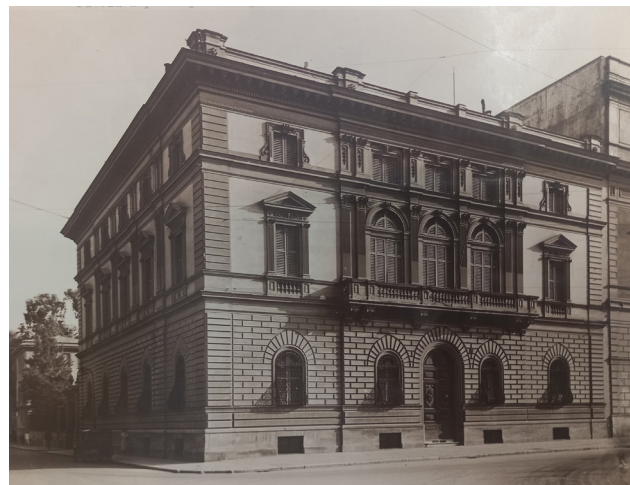
Fig. 7 - Roma, villino Centurini in piazza dell'Indipendenza, fotografia della facciata prima dell'adattamento a edificio scolastico (ACR, Governatorato di Roma, Conservazione del Patrimonio, Edificio scolastico in piazza dell'Indipendenza 7, posizione 1113, Planimetrie; Facciata principale su piazza dell'Indipendenza, s. d. [ma prima del 1936], f. sciolto).
