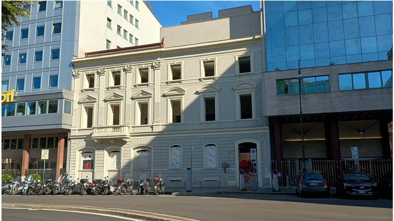
Fig. 5 - Roma, palazzo Servadio in piazza dell'Indipendenza, parte della facciata (foto dell'autrice, 2023).
