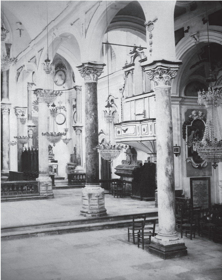
Fig. 4 - Santa Maria della Catena a Palermo prima dell'eliminazione delle strutture barocche (BARONE c.s.).
