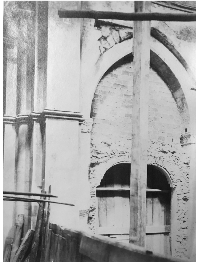
Fig. 7 - Cosenza. Cattedrale, arco del presbiterio verso la navata sinistra durante il restauro di fine XIX sec. La foto mostra l'arcata ancora tamponata dalle sovrastrutture barocche (struttura in mattoni). Dallo spessore murario emergono due antichi capitelli e, sopra la doppia ghiera dell'arco, la modanatura originaria non ancora reintegrata. Il fotogramma permette di essere certi dell'antichità del disegno del partito decorativo inquadrato (APC, C29, Foto 12).
