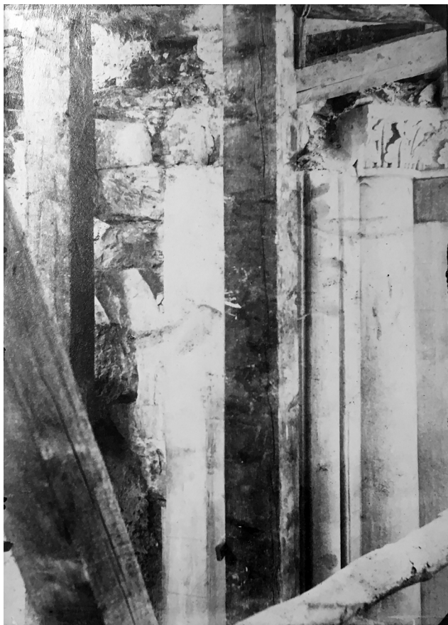
Fig. 13 - Cosenza. Cattedrale, pilastro della crociera durante il restauro di fine XIX sec. La foto raffigura uno dei pilastri polistili come rinvenuto. Non pare probabile che si tratti di una fase di ricostruzione visto lo stato di conservazione e la configurazione dei ponteggi, se ne desume l'originarietà del disegno d'insieme e la presenza di molti pezzi antichi, tra cui alcuni capitelli, in ottimo stato di conservazione (APC, C29).
