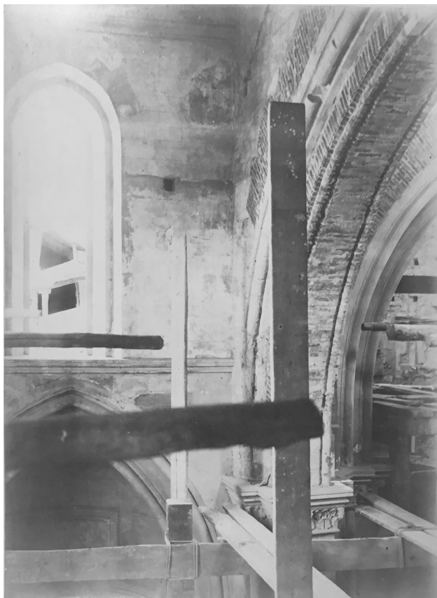
Fig. 5 - Cosenza. Cattedrale, finestra sull'abside sinistra durante il restauro di fine XIX sec. Dalla foto si evince come la volta sinistra del transetto non esistesse, né, tantomeno, sul muro se ne rintracciano resti. Al suo posto è la cornice medioevale, oggi visibile nei sottotetti. Sulla muratura sovrastante l'arcone si legge uno scasso a forma di arco, ancora visibile nel sottotetto, forse segno di una volta a botte ribassata, probabilmente incannucciata, di epoca barocca (APC, C29, Foto 8).
