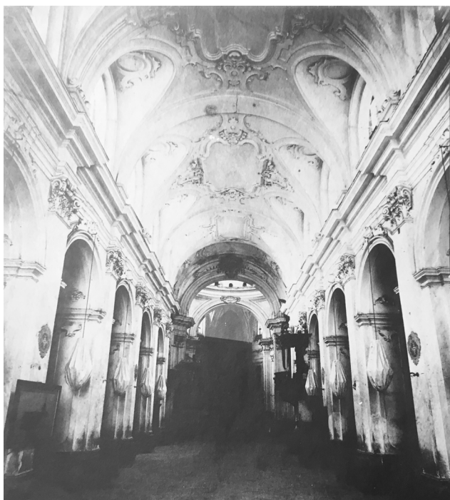
Fig. 9 - Cosenza. Cattedrale, interno del duomo all'inizio del restauro di fine XIX sec. Si riconosce, sulla sinistra, la sezione del primo progetto di Pisanti per la cattedrale che consente la datazione del fotogramma. Sullo sfondo si intravede il presbiterio barocco, esso si riscopre caratterizzato da una cupola su pennacchi sferici e da un'abside coperta da una volta a ombrello con profilo acuto, probabilmente tardogotica, resa barocca dagli stucchi (APC, C29, Foto 16).
