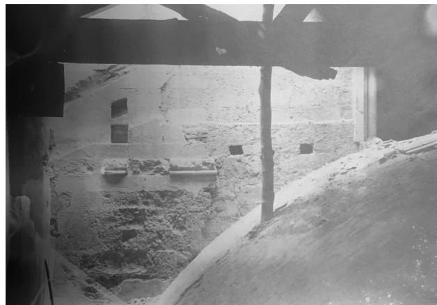
Fig. 11 - Cosenza. Cattedrale, sottotetto dell'abside centrale durante il restauro di fine XIX secolo. Sulla destra si intravede lo stipite della bifora più esterna dove è applicata una colonnina oggi assente, se ne desume che il profilo della bifora fu alterato durante i restauri. A sinistra, si notano i segni di quella che in origine doveva essere una cornice esterna. Essa doveva correre lungo tutta la parete di fondo (APC, C29).
