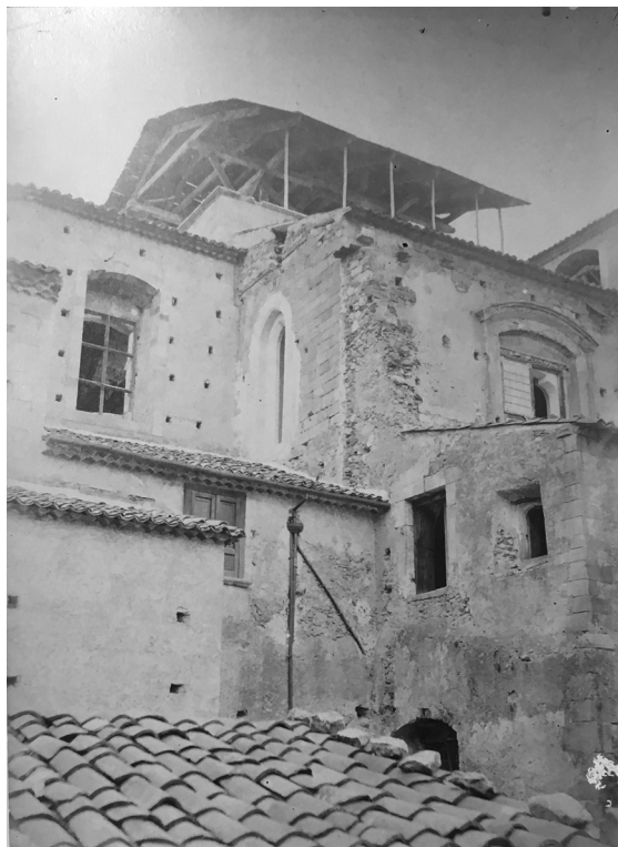
Fig. 1 - Cosenza. Cattedrale, il transetto sinistro durante il restauro di fine XIX sec. La foto mostra la copertura del transetto sinistro, in origine ad unica falda e lo spigolo del tiburio medioevale a pianta quadrata, ingentilito da una modanatura. Il concio di pietra aggettante alla sinistra dell'attuale rosone, precedente ai restauri, data la quota, potrebbe essere il resto della cornice che marcava il profilo del tetto del transetto (APC, C29, Foto 2).
