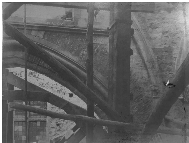
Fig. 3 - Cosenza. Cattedrale, arco laterale della crociera e bifora durante il restauro di fine XIX sec. Il documento testimonia, come sottolinea la didascalia, la presenza ab antiquo di una delle quattro bifore sotto la crociera centrale e della volta stessa. Si leggono due delle basi delle colonnine e la modanatura al disotto della finestra. È visibile anche il capitello su cui poggia la crociera centrale e l'imposta della stessa (APC, C29, Foto 4).
