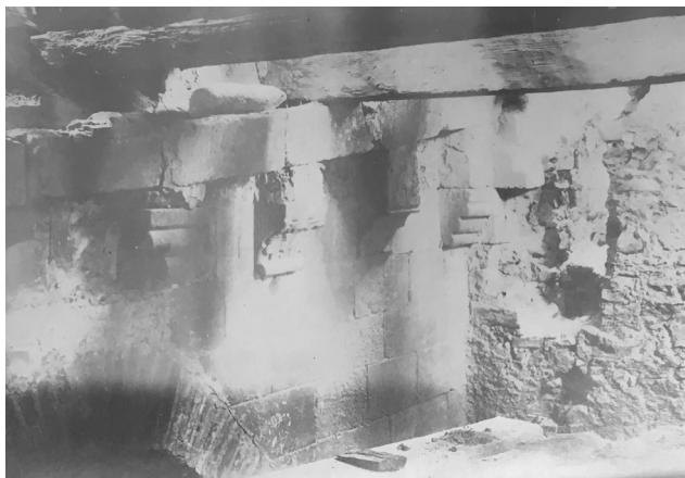
Fig. 10 - Cosenza. Cattedrale, cornice di gronda sinistra sul transetto durante il restauro di fine XIX sec. La foto mostra la cornice visibile ancora oggi dal primo livello del campanile e le relative mensole decorate con fantasiosi motivi tutti differenti. La cornice inclinata seguiva la pendenza del tetto del transetto, resti analoghi sono rintracciabili sul transetto verso corso B. Telesio (APC, C29).
