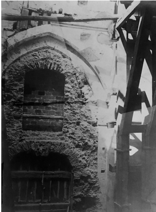
Fig. 6 - Cosenza. Cattedrale, arco del presbiterio verso la navata destra durante il restauro di fine XIX sec. Nella foto si riconoscono l'arco a doppia ghiera ancora tamponato e sulla destra, all'imposta dell'arco, il capitello. Tangente alla chiave dell'arco è la modanatura antica non ancora reintegrata. Il fotogramma permette di essere certi dell'antichità del disegno del partito decorativo e molto possibilisti sulla conservazione della materia originaria (APC, C29, Foto 11).
